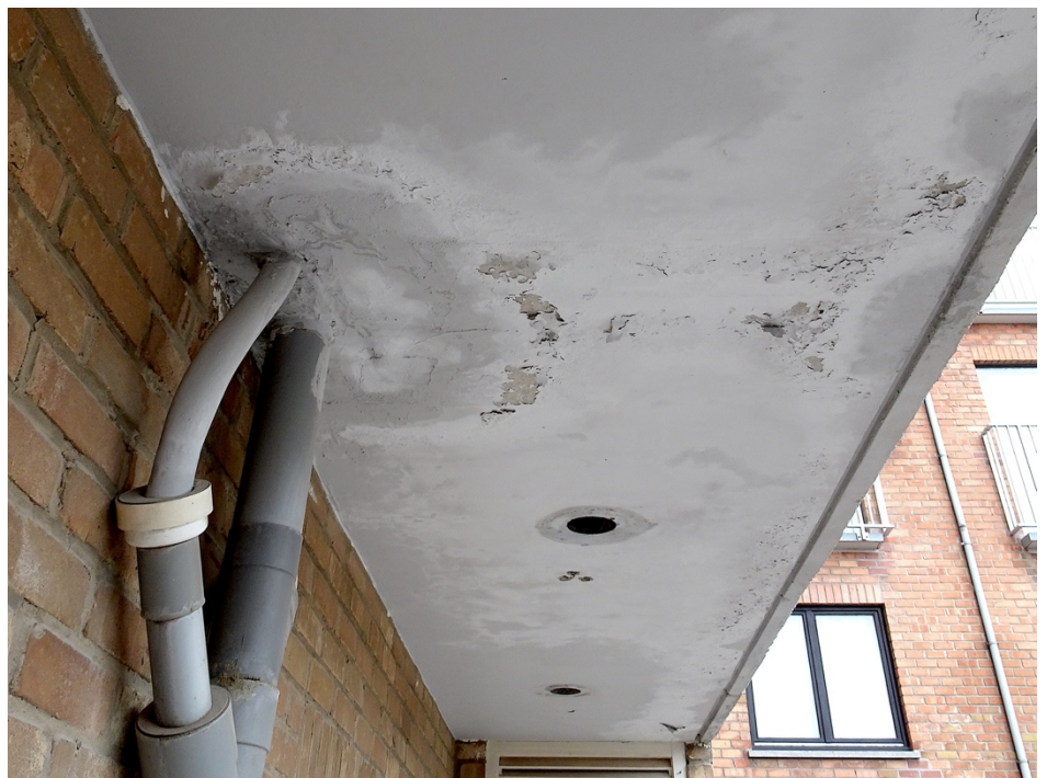
CiBO | Residentie ACAPULCO Voorbeeld van kernboringen, balkonhemel 2I, vloerplaat 3I.
