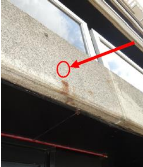
Kernboring voorgevel
