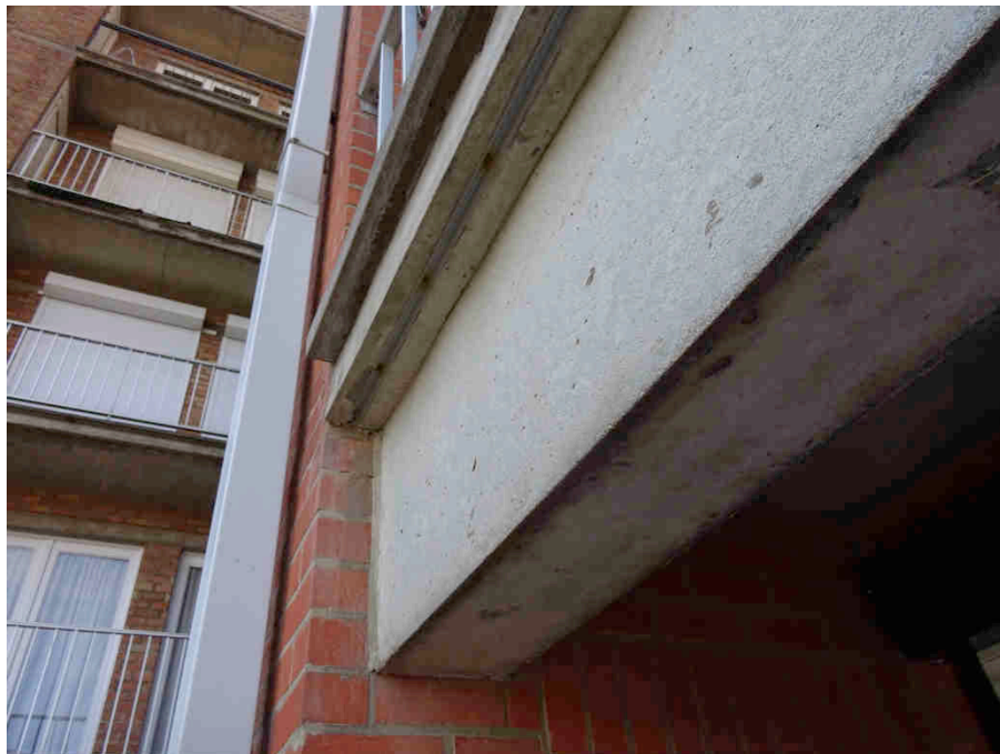
FOTO 7. Residentie ANITA, achtergevel : Detailzicht op balkonopbouw : gevelbalk (skelet), vloerplaat, blauwsteen met tegelvloer, aluminium leuning.
