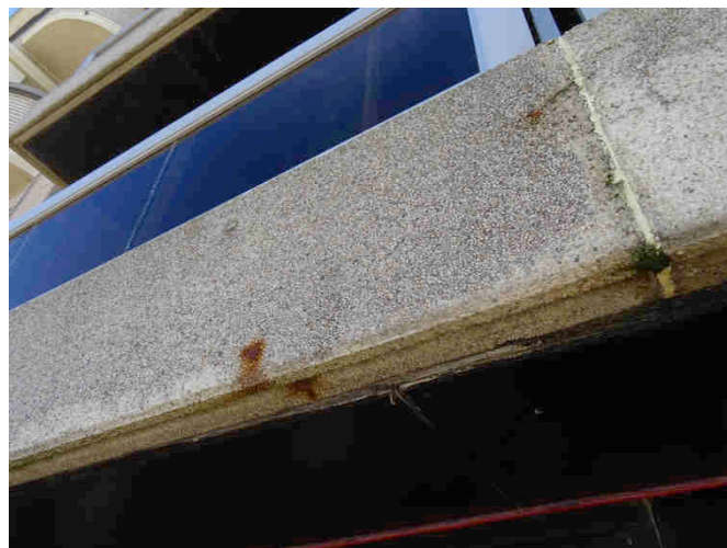
FOTO 5. Residentie ANITA, voorgevel : Detail van vervuiling en plaatselijk schadebeeld op frontpaneel balkonelement.
