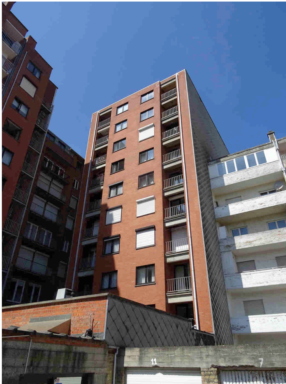
FOTO 2. Residentie ANITA, achtergevel : Algemeen zicht
