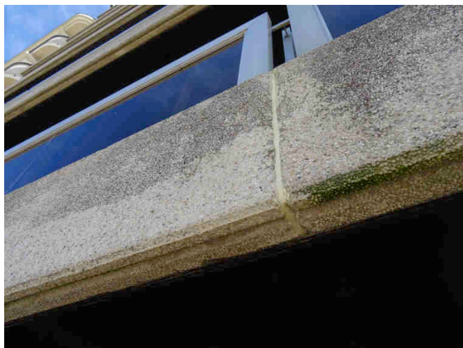
FOTO 5. Residentie ANITA, voorgevel : Detail van vervuiling en plaatselijk schadebeeld op frontpaneel balkonelement.
