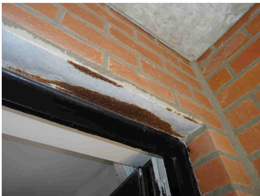
FOTO 8. Residentie ANITA, achtergevel : Detailzicht op loggia : buitenparement in metselwerk, gegalvaniseerde lateiprofielen, houten schrijnwerk.
