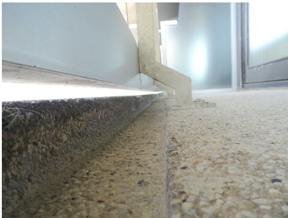
CiBO | Residentie ANITA Afvoergoot (naakt beton).
