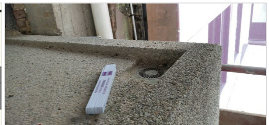
Oude afvoerpunten te verwijderen & nieuw te voorzien
