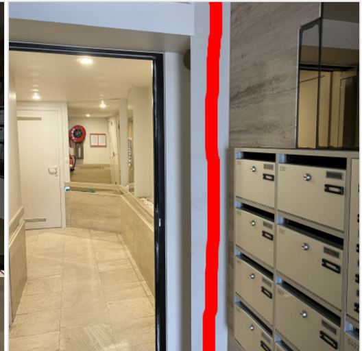
te verwijderen houten kolom/binnenafwerking
