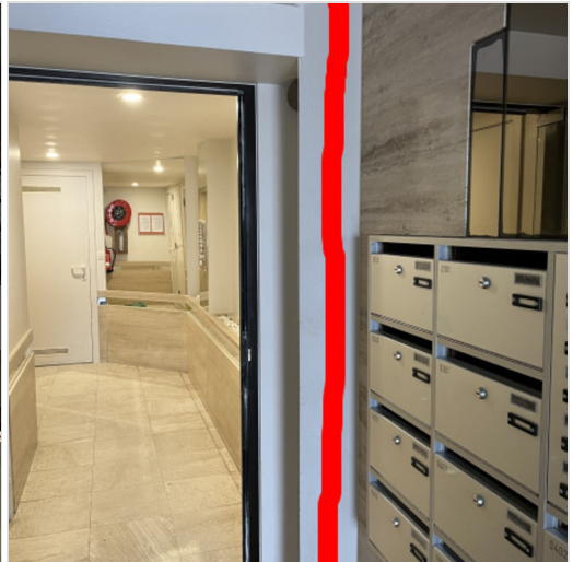
te verwijderen houten kolom/binnenafwerking
