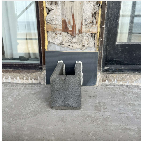
aanzet stepoc kolom
