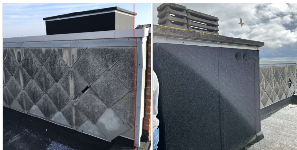
randaansluitingen onafhankelijk maken van achtergevel schouw buurgebouw
