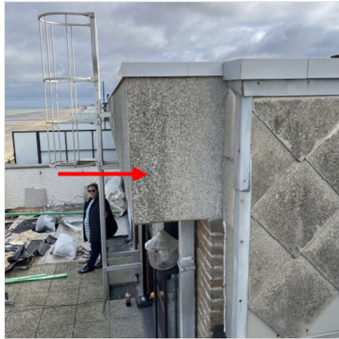
randaansluiting voorgevel en blinde zijgevel
