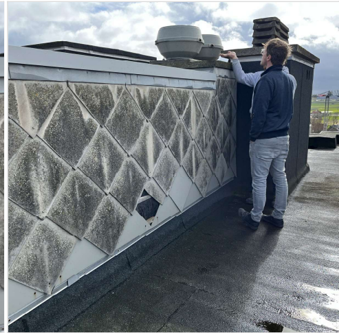
plaatsen profiel op deksteen om dichting op te verkleven/bevestigen
