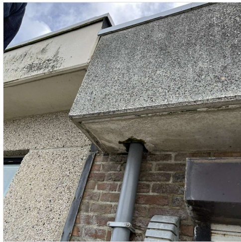
randaansluiting voorgevel en blinde zijgevel
