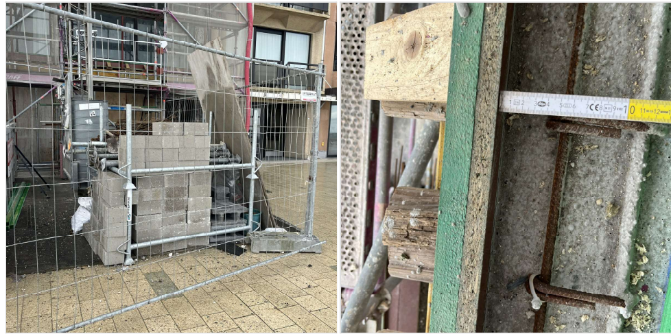
te gebruiken betonblokken creatie penant tussen ramen
