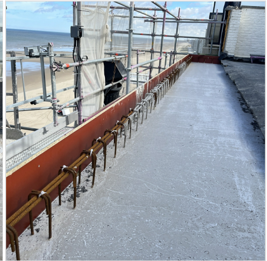
V10 luifel aangestort, opstand nog uit te voeren
