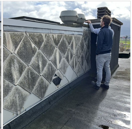
plaatsen profiel op deksteen om dichting op te verkleven/bevestigen
