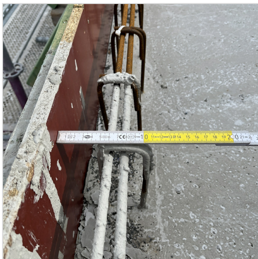
staven manipuleren ifv respecteren 12 cm dikke opstand
