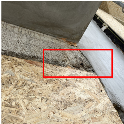
uitvoeren betonherstel balk
