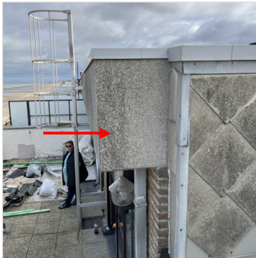
randaansluiting voorgevel en blinde zijgevel
