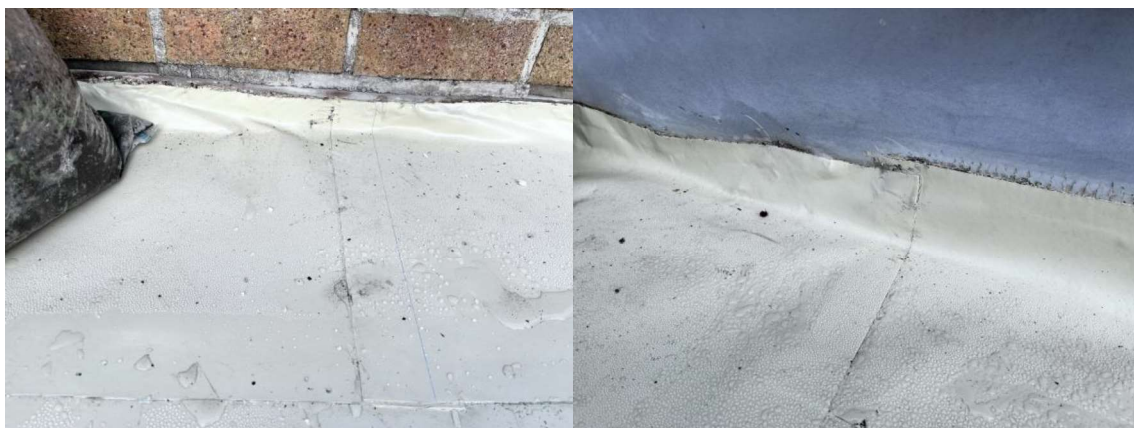
Het nieuwe pvc-membraan wordt boven op het oude gelast ...
