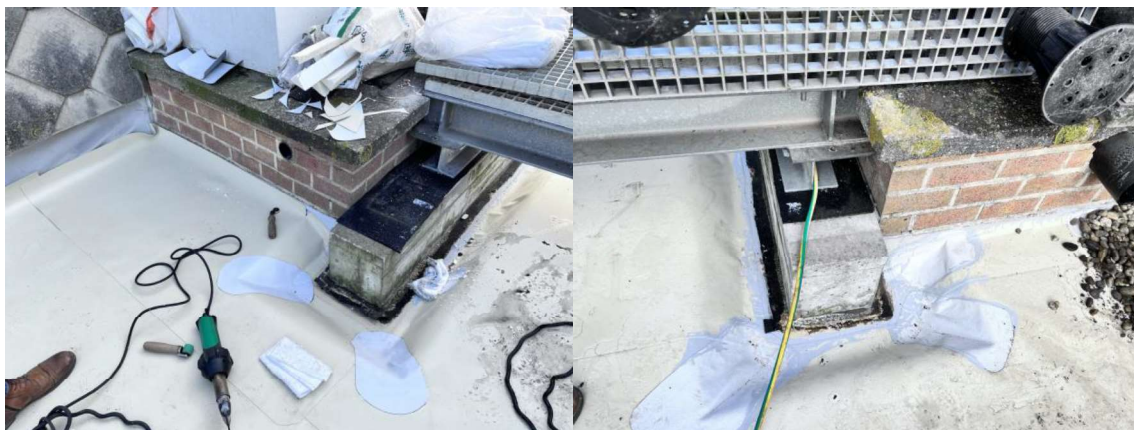
Sokkel waarop de technische installaties steunen zit verdiept ...
