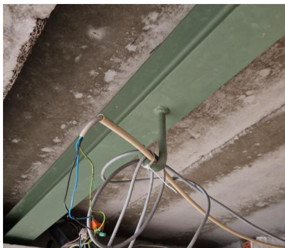
Te verwijderen hijsoog (men kan gebruik maken van een balkenklem)
