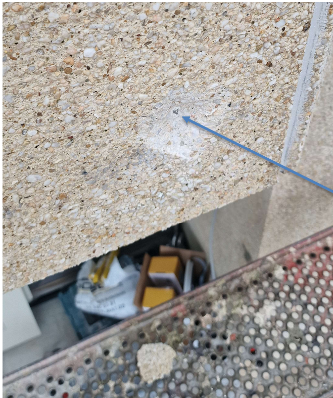
Afgesprongen beton
