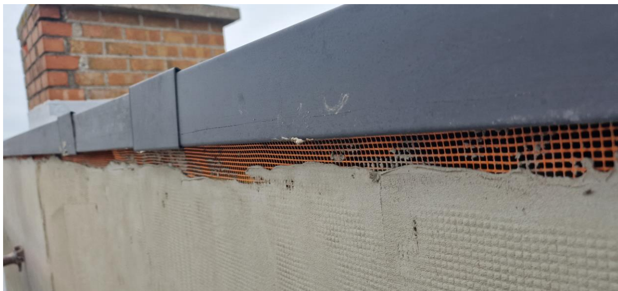
Isolatie moet tot tegen de verbrede dakrand komen met zwelband!!!
