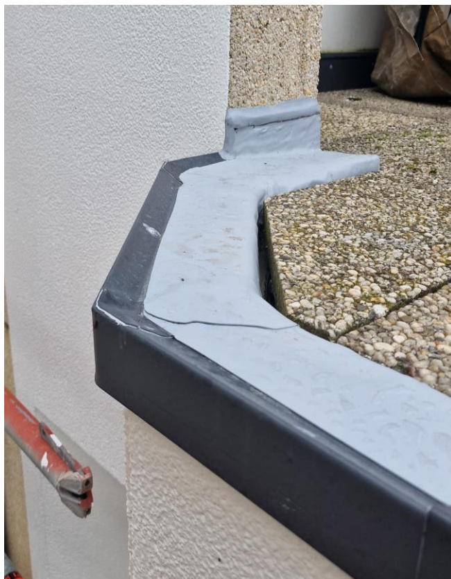
Afwerking opkant dakrand
