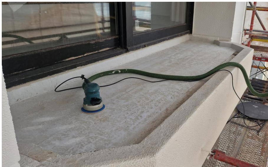
Eerste dichtingslaag wordt opgeschuurd
