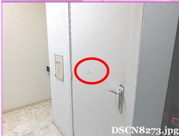
Kleine beschadiging in het deurblad van deur naast afvalkoker.
