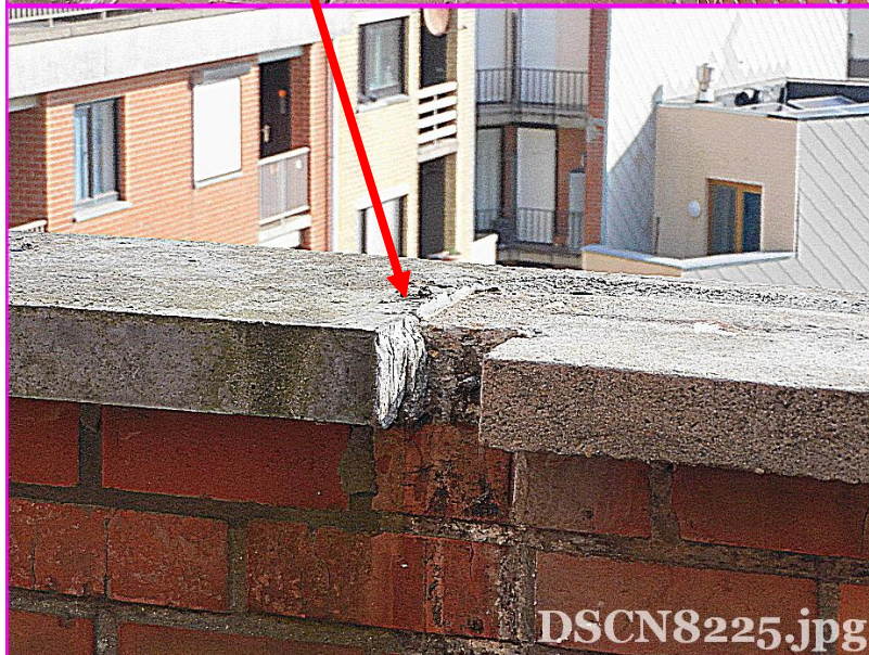
Stuk uit muurdeskel geslepen voor de plaatsing van berghok (ondertussen afgebroken).
