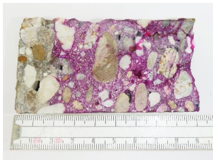
Figuur 36 – carbonatatie diepte kern 5
