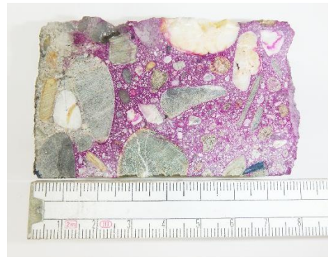
Figuur 35 - carbonatatie diepte kern 4
