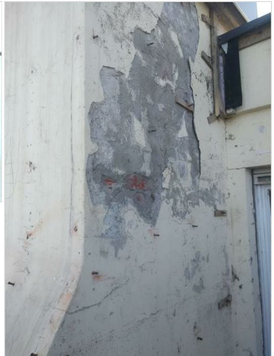
Verwijderen losse cementering
