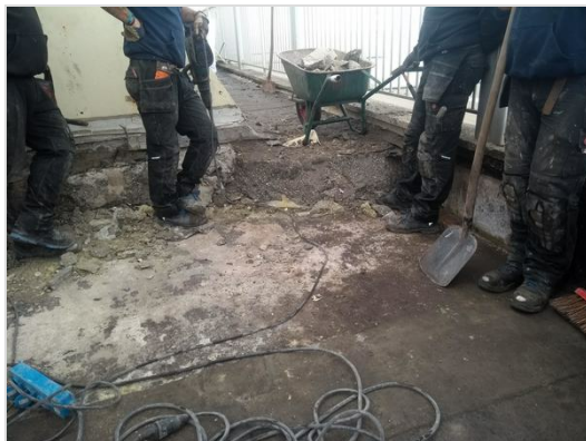
Reeds +- 100m 2 uitgebroken
