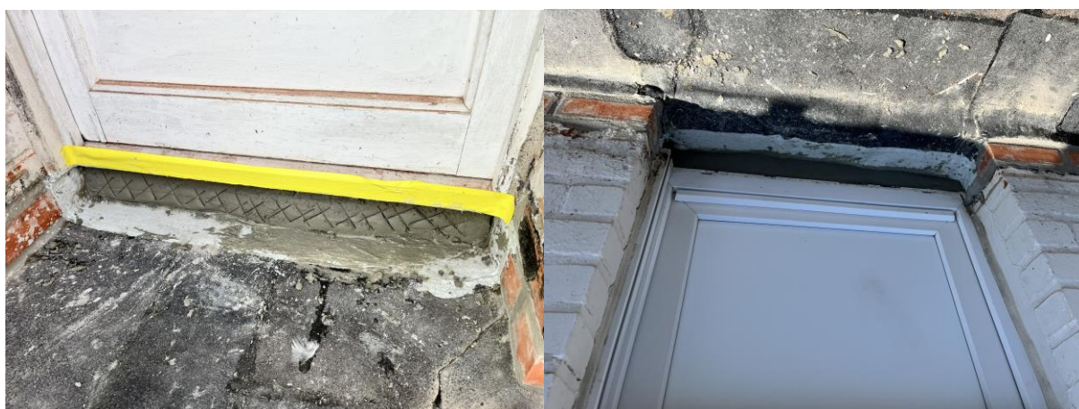
Na uitharding van het hars wordt onder de deuren R4 wapeningsmortel aangebracht ter ondersteuning ...
