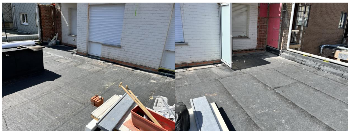
Waar de bergingen werden afgebroken, dient de gevel nog gecoat te worden ...
