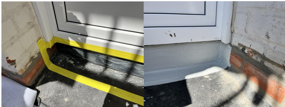
De dichting onder de deuren wordt aangewerkt met PMMA-hars met wapeningsvlies ...
