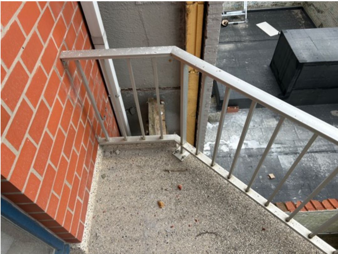
Foto 10: Appartement bus 202, balustrade aan achterzijde
