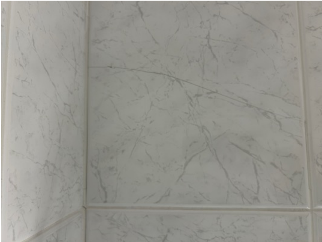
Foto 7: Appartement bus 702, muurbetegeling badkamer
