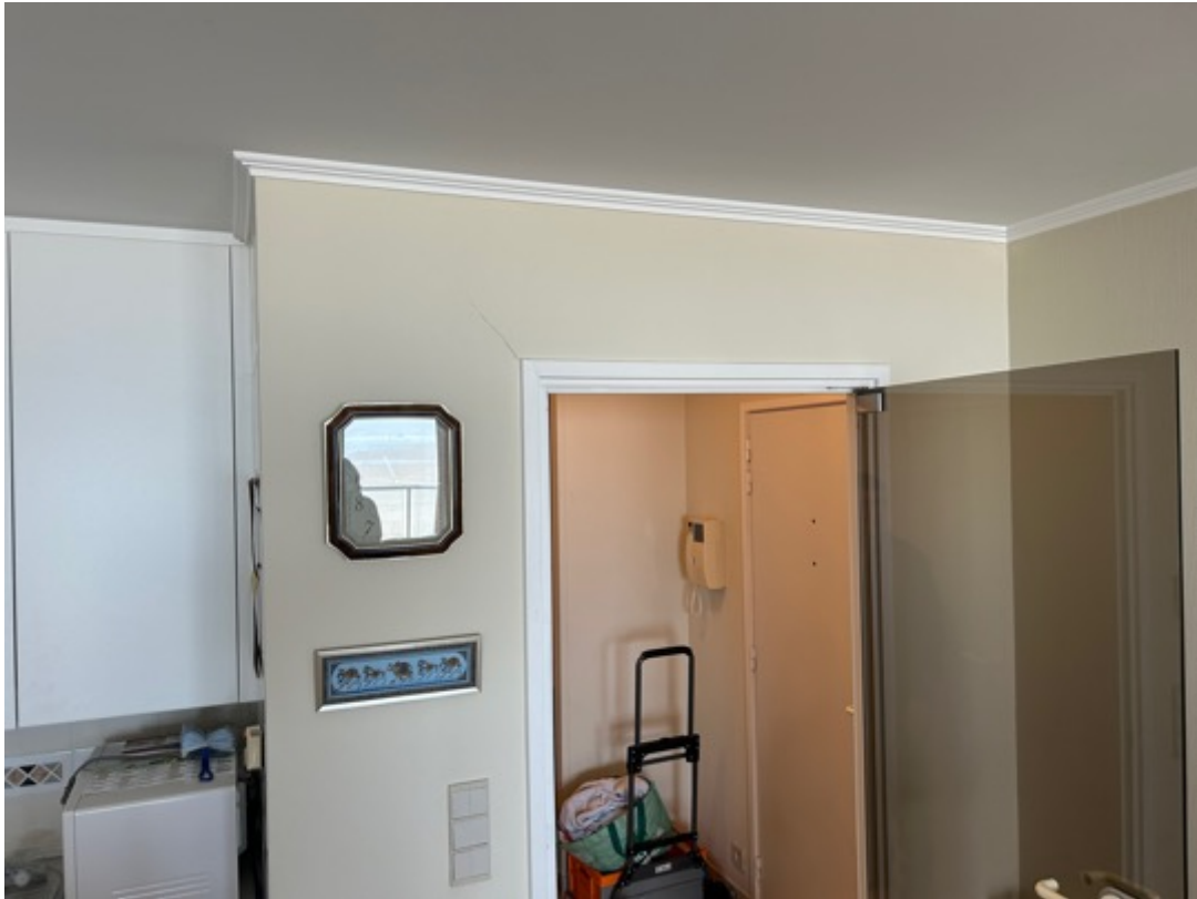
Foto 11: Appartement bus 202, leefruimte
