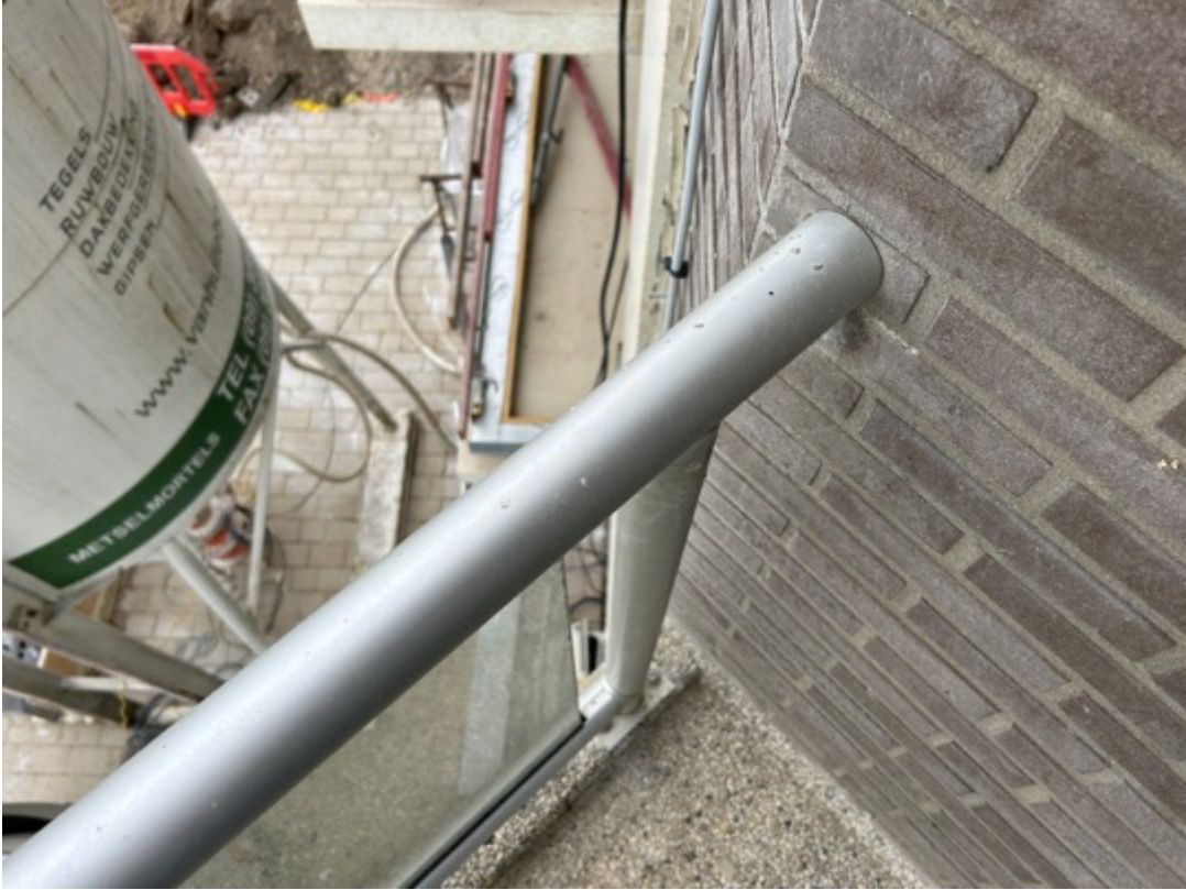
Foto 9: Appartement bus 202, balustrade aan voorzijde
