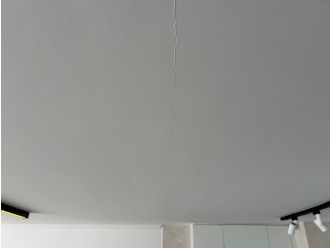
Foto 5: Appartement bus 702, leefruimte
