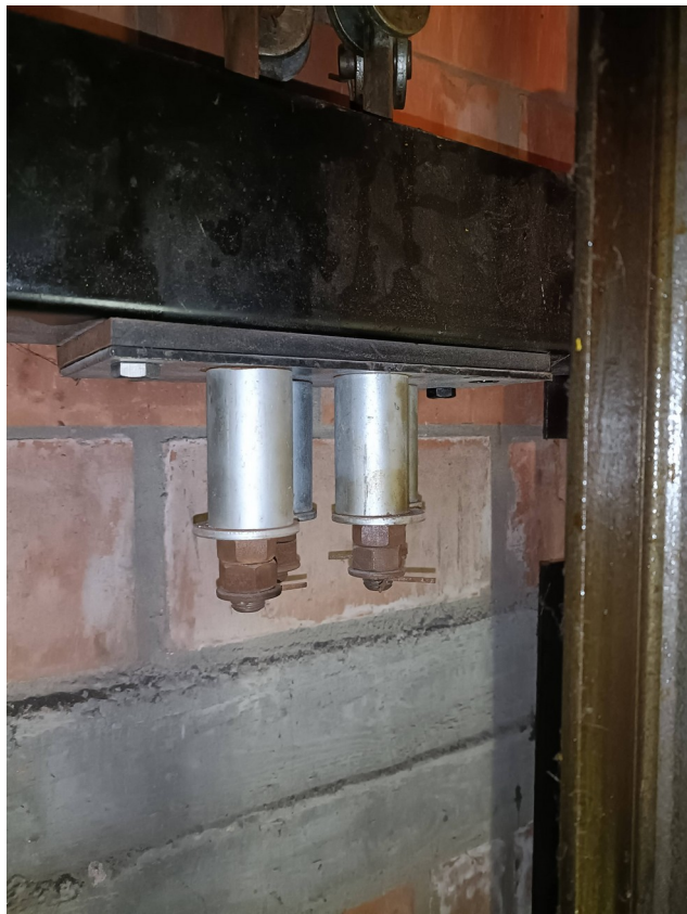
MITSOU : metalen cilinders in de plaats van vering.
