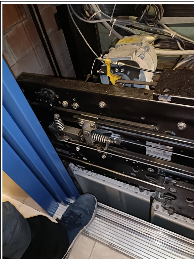
Wittur deuroperator. Ietwat verouderd, maar wel degelijk.
